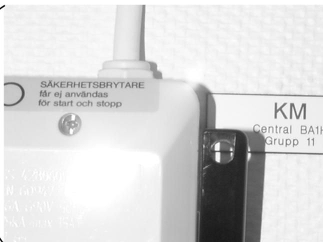
I föreningens tvättstugor är de anslutna apparaterna anslutna till starkströmsnätet via s.k. säkerhetsbrytare (se ovan bild). **Dessa brytare skall normalt alltid vara påslagna och skall endast användas vid service och som nödbrytare.**
