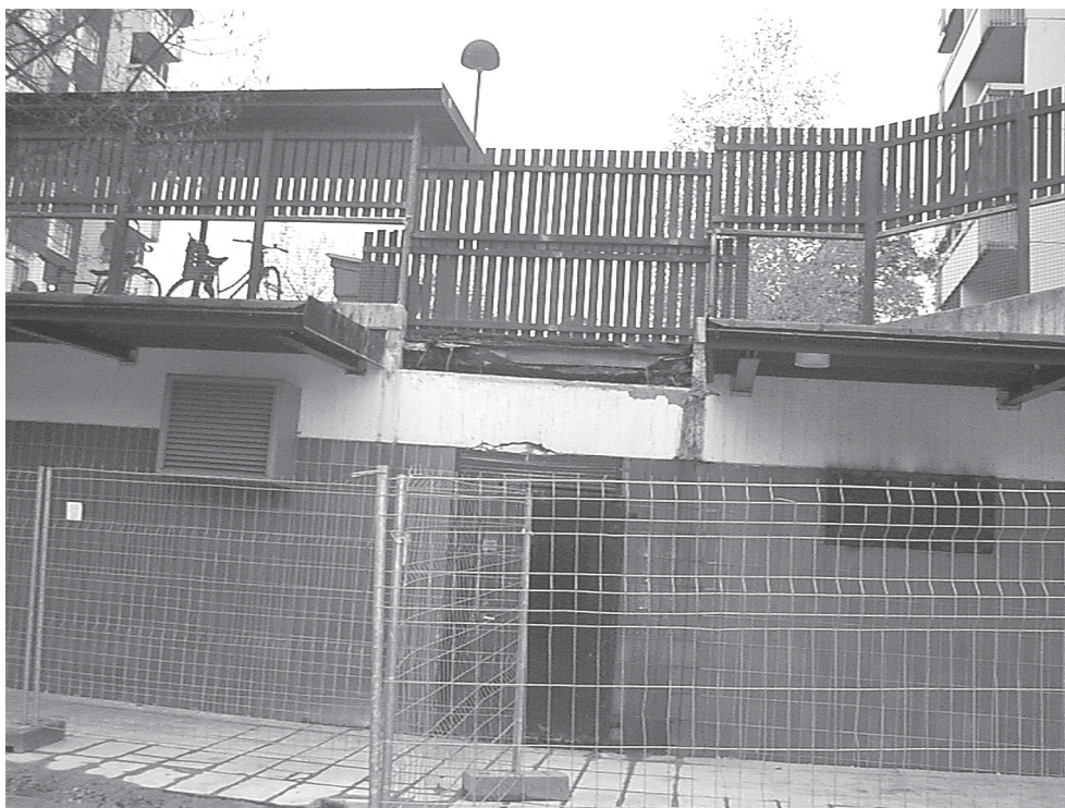
Nedmonterad betongtrappa mellan hus 16 och hus 17. Ersättes med ståltrappa.
